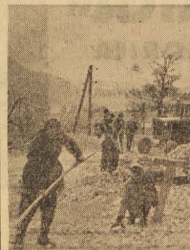
Delavci in delavke pri delu na cesti pri Planini
