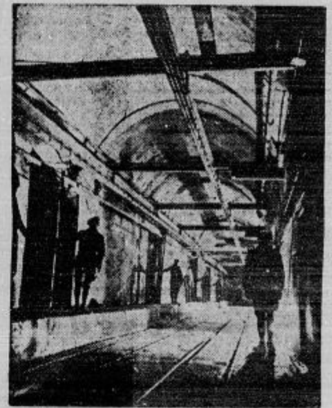
Podzemsko skladišče za orožje na Maginotovi bojni črti
