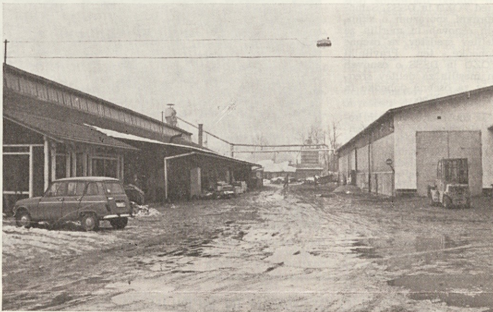
Dvorišče bo treba čimprej asfaltirati
