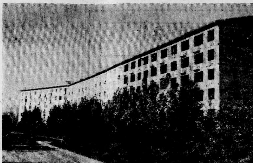
STANOVANJSKI BLOK »BUMERANG« na Pobrežju v Mariboru je že sprejel prve stanovalce. Foto: J. Peštal
