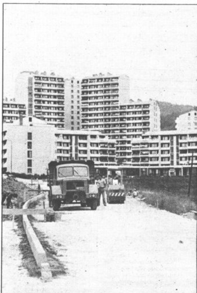
Delavci Vekosa so prav te dni opravili vsa pripravljala dela in položili asfaltno prevleko na priključku ceste Vrnjačka banja na Celjsko cesto. Čeprav bo na tej cesti potekal enosmerni promet za osebna vozila so uporabniki veseli dokončne ureditve doslej neurejenega dela cestišča.
