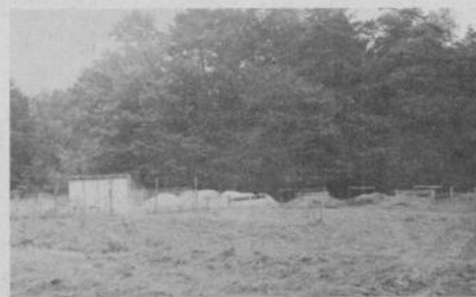
Črna gradnja na jasi sredi gozda v zelenem pasu Ptuja, „pljučih“ mesta. Postavili so ograjo, uto za orodje, na hitro navozili nekaj gradbenega materiala in zabetonirali temelje. Vse to pa ne bo pomagalo, gradnjo bo treba odstraniti.
