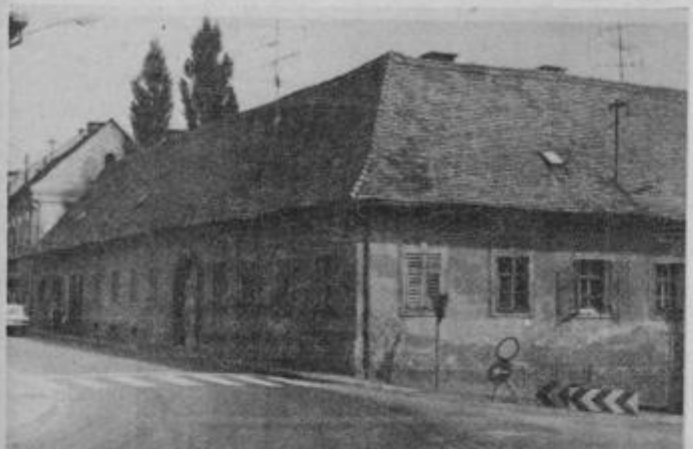
Nekdanja Banova hiša bo namenjena SIS in DPO občine Ormož. Foto: zk
