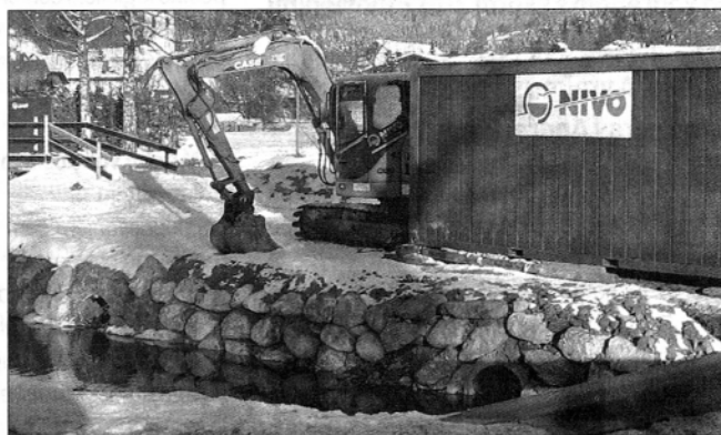
Delavci podjetja Nivo sanirajo brežine in čistijo strugo Trnave (foto: Benjamin Kanjir)
