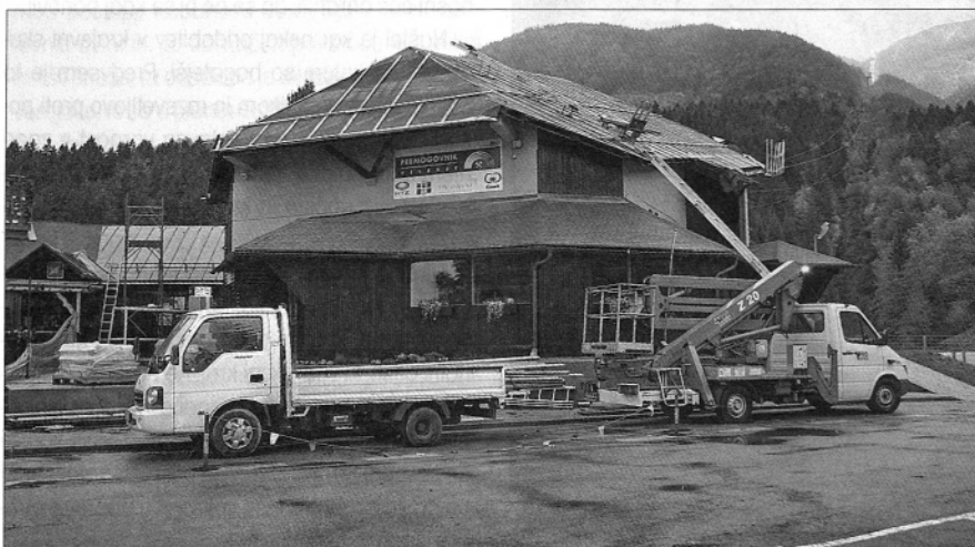
Obnovitvena dela na spodnji postaji nihalk v Žekovcu (foto: Marija Lebar)
