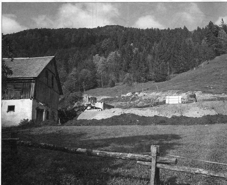
Gradbena dela na cesti v Robanovem kotu (foto: Marija Lebar)
