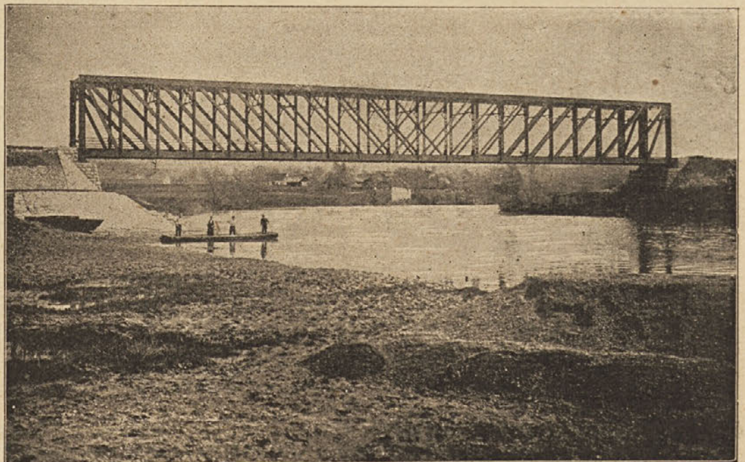
Belokranjska železnica: Most čez Kulpo pri Metliki (deželna meja med Kranjsko in Hrvatsko). Fot. T. Kramer v Metliki.
