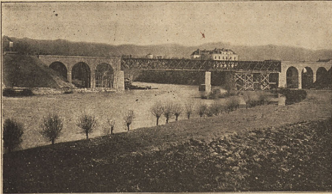
Belokranjska železnica: Most čez Krko pri Novem mestu.
