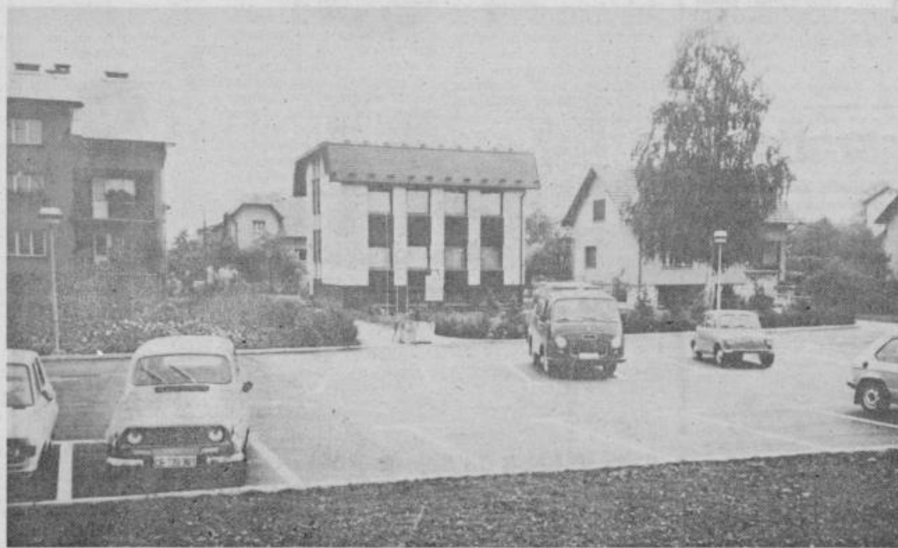
V sredini slike je stavba obrtne zadruge v Žalcu s pravkar dograjenim novim parkirnim prostorom.
