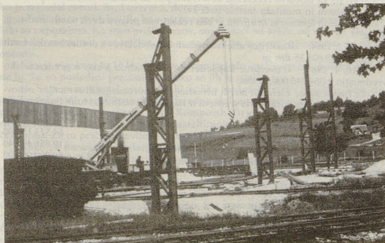
Pričetek postavljanja jeklene konstrukcije za halo za žlindro pri Jeklarni
