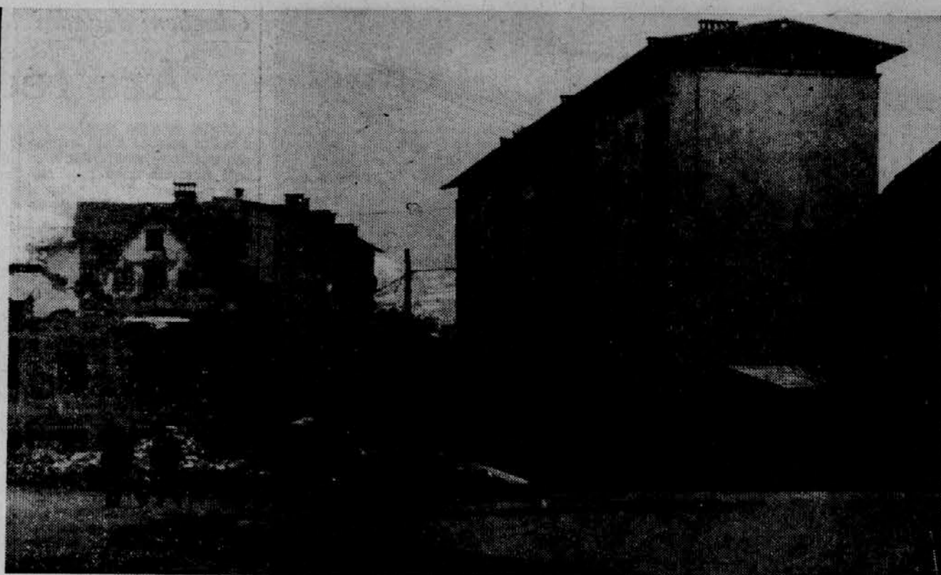
V IDRIJI RUŠIJO STARE HIŠE — Delavci podjetja za urejanje hudournikov so začeli rušiti dvesto let stare rudarske hiše v Ulici Staneta Rozmana. Na tem mestu bodo zgradili nove sodobne zgradbe. Foto: Matej Brus
