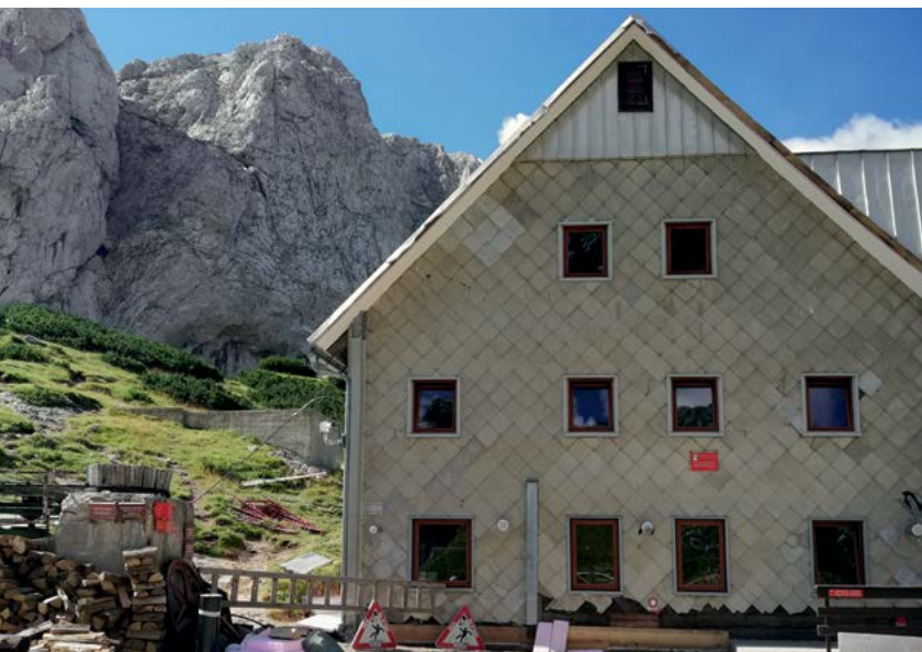
Koča med prenovo. Poleg oskrbniške ekipe so bili tam še ekipa krovcev ter delavci iz planinskega društva. Foto Marko Matjašič
