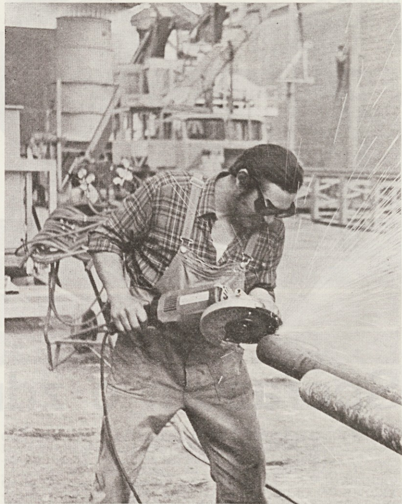
Montažna dela v novi tovarni ivernih plošč
