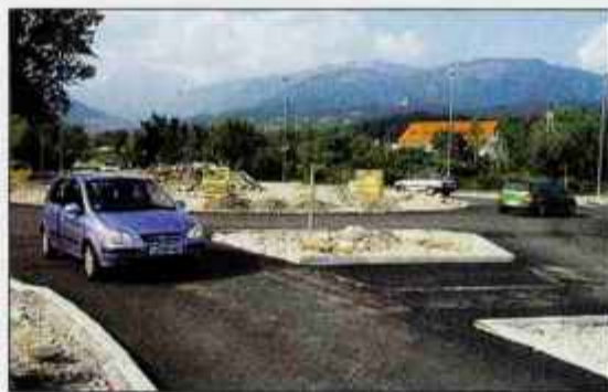
Krožišče pri KIK-u je že asfaltirano in dobiva končno podobo.
