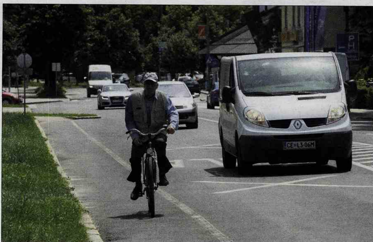
Na Ljubljanski ulici (tik pred policijo ...) je primer slabo vidne talne označbe za kolesarsko stezo. In tudi ni prometnega znaka, da se ta naenkrat konča. Bo zaradi tega kdaj prišlo do nesreče?
