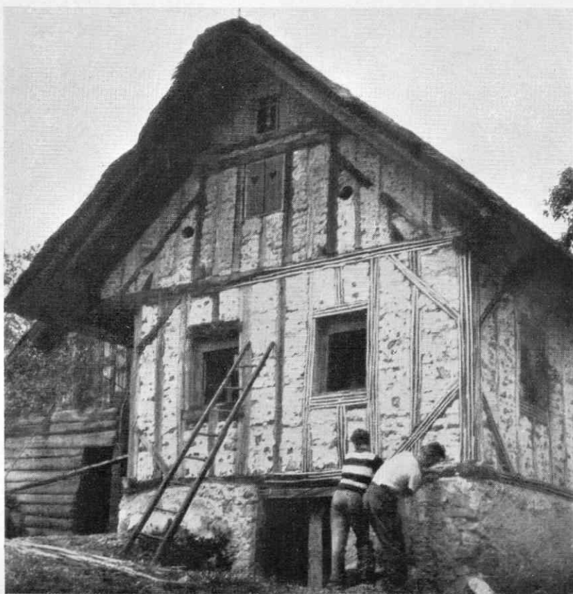
Zidanje predalčnih sten v okolici Žužemberka na Dolenjskem
