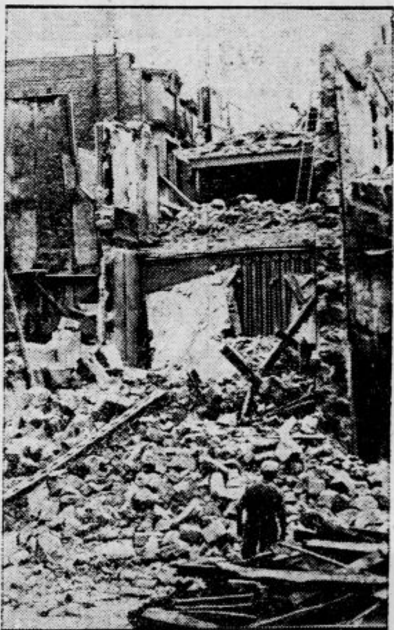
V sredini starega Pariza, v Rue Mouffetard, se je podrla hiša in pokopala pod seboj tri delavce. Šele po dolgem delu se je posrečilo osvoboditi ponesrečence.
