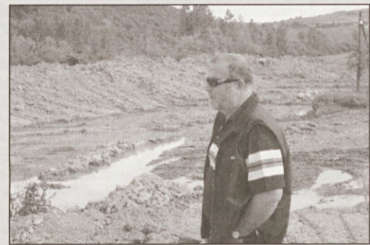
Na fotografiji PU: Nasipavanje močvirnega zemljišča pri Bandelu.
