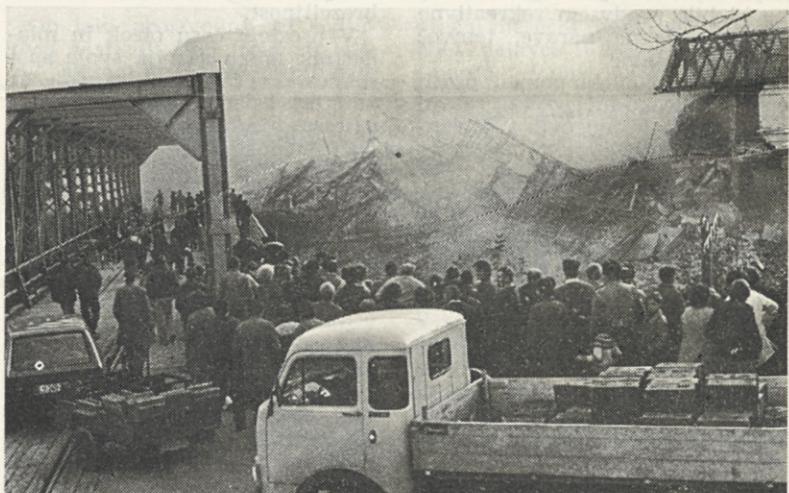
Po končanem rušenju so se opazovalci pomaknili bliže. Nekaterim, ki so včasih delali v tej stavbi, se je prav milo storilo pri srcu ob pogledu na kup ruševin. Pa tudi sama stavba je uničenju kljubovala, saj je po miniranju en del še vedno stal (na sliki desno) in ga je bilo treba posebej zrušiti z dodatnimi minami
