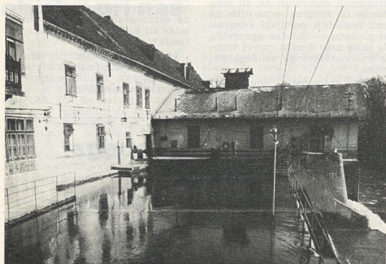
Fužine 24. oktobra; v kanal je zopet preusmerjen tok Ljubljanice, stroj za čiščenje rešetak dela, agregat za pridobivanje električne energije obratuje
