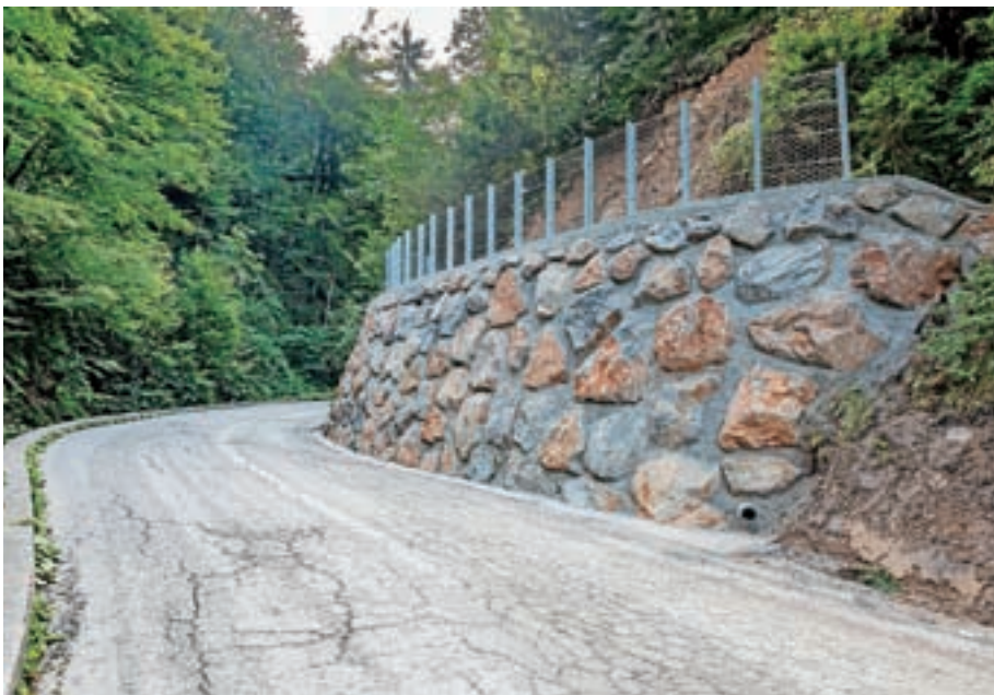
Plaz ob cesti Trnovec-Topol je saniran.
