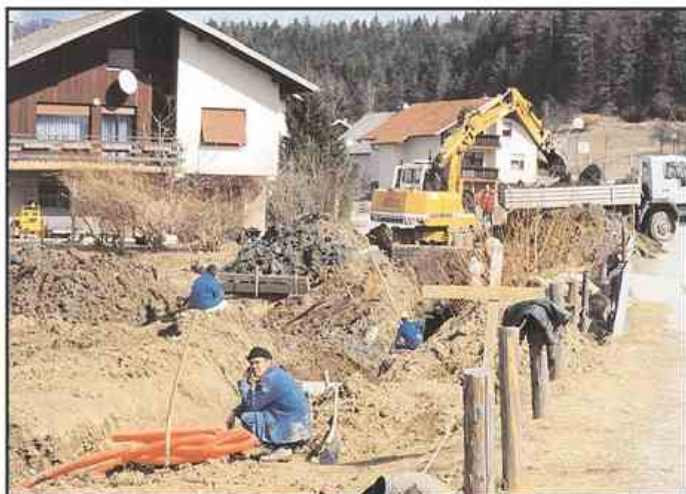
V KS Ravne v teh dneh namenja pozornost ureditvi kanalizacije
