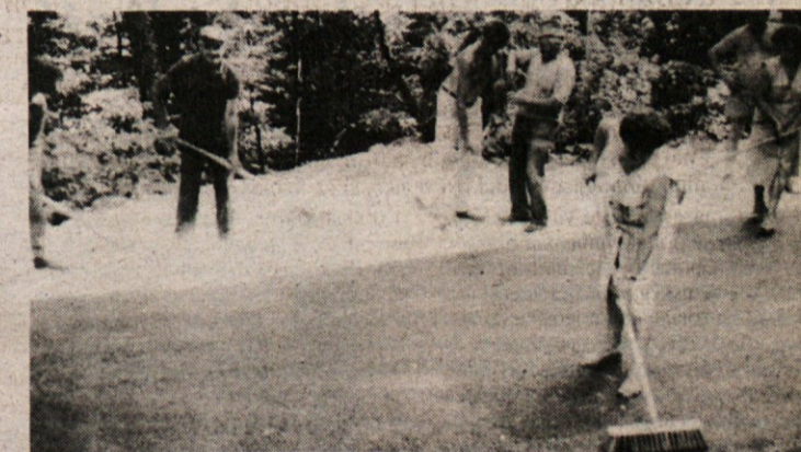
NIČ PODARJENEGA — Vaščane Mestnega vrha boljlo zlonamerne pripombe, ki prihajajo iz ust nevoščljivih ljudi nekaterih vasi, kjer še nimajo asfalta. Zato so odločno vztrajali, da jih obiščemo ob zaključnih delih, potem ko so nedavno novomeški cestarji položili 2200 metrov asfalta. V hudi vročini in sparni so vaščani urejali bankine, ženske, vjane trgega dela, pa so dobile žulje — od pometanja ceste od vrha vasi do kapelice pri Kumnu. Vaščani so hvaležni vsem za pomoč, poudariti pa je treba, da je vsako izmed 11 gospodinjstev prispevalo okrog 50 ticočakov, najmanj 200 udarniških ur, hrano za delavce itd. (Foto: P. P.)
