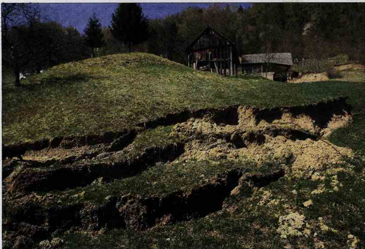
Vsak dan se pojavi nova razpoka, grožnja plazenja pa ne pojenja.
