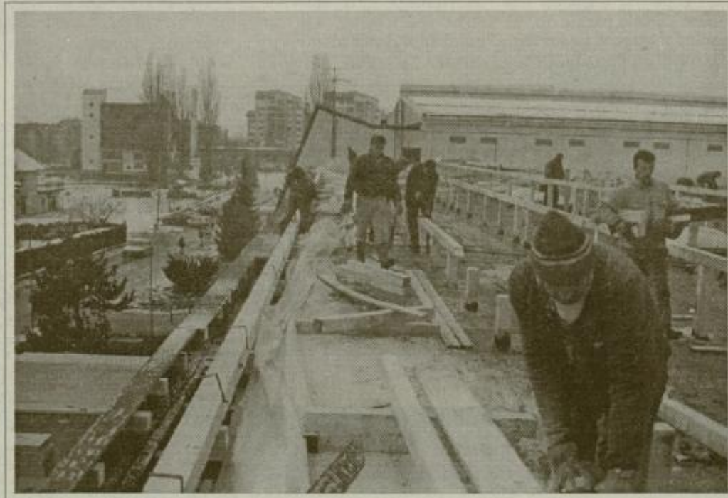
Delavci GP Pluton iz Sv. Lovrenca pri gradnji nove strehe na žalski osnovni šoli.
