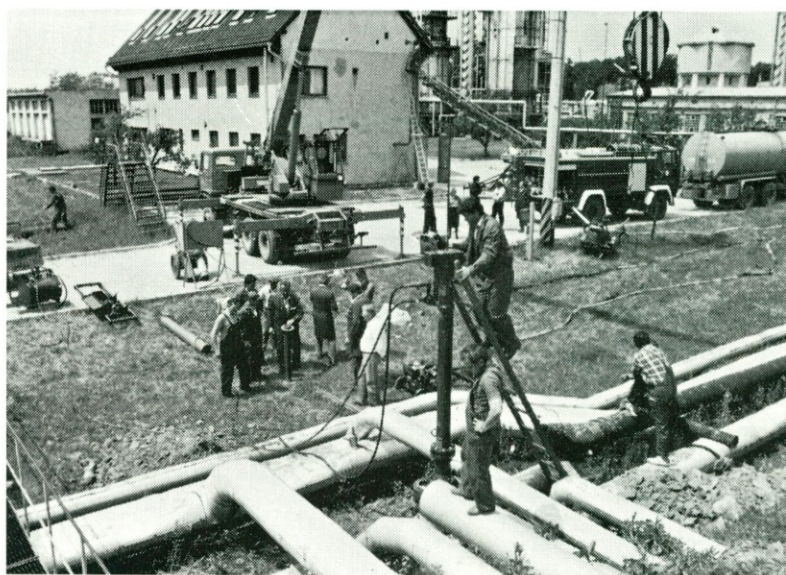
Montiranje posebnega ventila za praznjenje naftovoda nad merno-sprejemno postajo in rezervoarskim prostorom. Iz tega dela naftovoda je bilo namreč potrebno izčrpati surovo nafto
