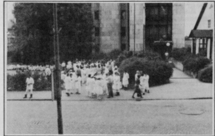
17. junija pred upravno stavbo Perutnine
