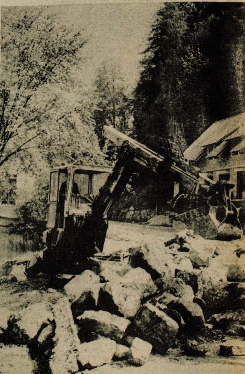
Bled – V teh dneh so na Bledu delavci Vodnogospodarskega podjetja Kranj uredili del obale Blejskega jezera, ki se je že pogrezala. Obala je zdaj primerno urejena od vile Bled do Mlina in to vsekakor pomeni za turistični kraj precejšnjo pridobitev. – Foto: DS.
