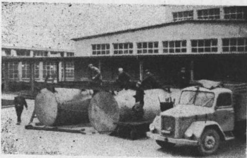
1. Poizkusna montaža črpalnice — pred delavnico El. strojne obrata. Na sliki doma izdelana rezervoarja, 192 cm premera in 600 cm dolžine — t. j. 17,4 m 3 . Rezervoarja sta preizkušena z vodnim trakom 3 atm. Sila v rezervoarju pri tem pritisku pa znaša ca. 12.500 ton.
