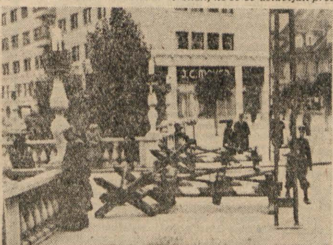
PREGRADILI SO LJUBLJANO ČEZ IN ČEZ, TUDI TROMOSTOVJE JIM JE BIL NEVARNO
