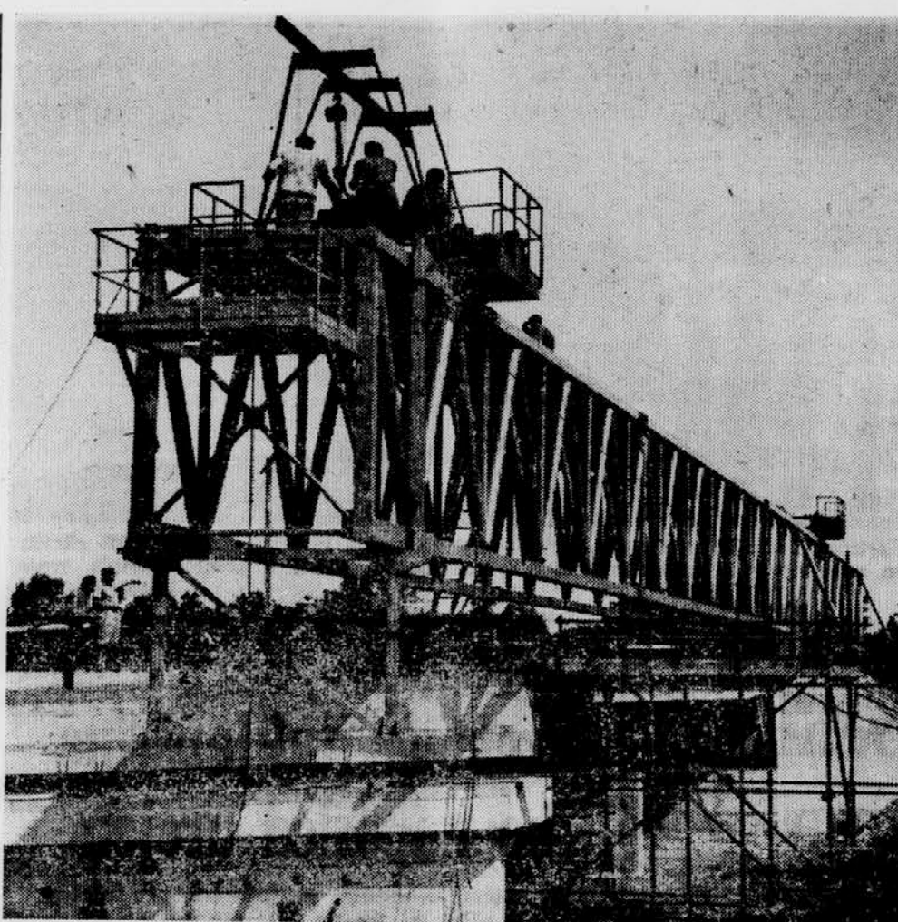
TEKMA S ČASOM — Graditelji mostu čez Muro pri Veržetu kljub slabemu vremenu optimistično napovedujejo, da bodo do dneva republike ta velik objekt dogradili. Izkušeni delavci mariborskega podjetja »Gradisa«, ki je izvajalec del, so že pred časom na najbolj sodoben način zbetonirali nosilne stebre, sedaj pa montirajo prednapete nosilce. Na sliki: montaža težke nosilne konstrukcije. Foto: Boro Borovič
