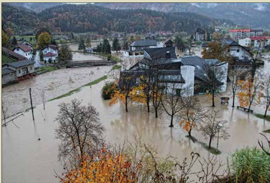
Poplavljen je bilo središče Nazarij, dom kulture, gasilski dom, stanovanjski bloki ... (Foto: UK)
