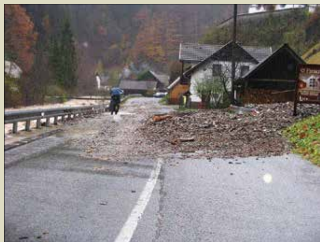
Na Solčavskem je izjemno deževje povzročilo resne težave na cestah in mostovih. (Fotodokumentacija Občina Solčava)
