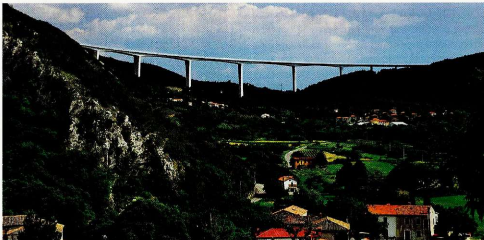
Viadukt Črni Kal nad vasjo Gabrovica
