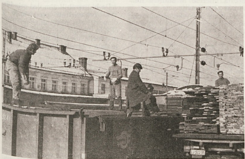
Delavci špedicije na Rakeku pri vsakodnevem delu: nove in nove pošiljke
