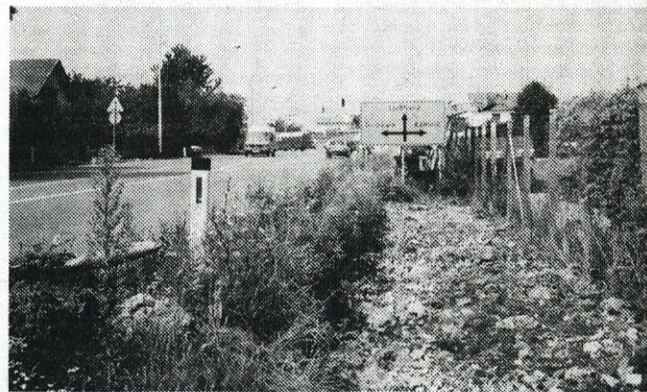
Gradnja napajalnega plinovoda 5 bar do MRP Duplica ob obvoznici.
