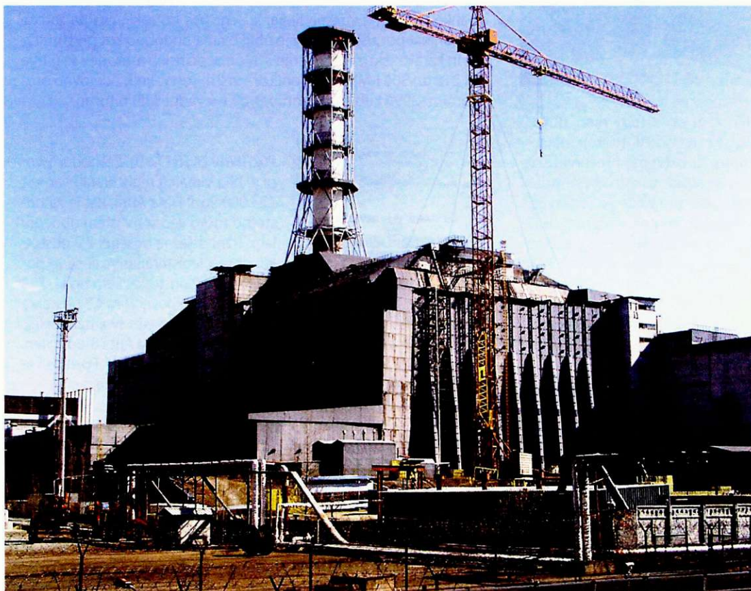
Reaktor obdaja betonski sarkofag, potreben obnove.
