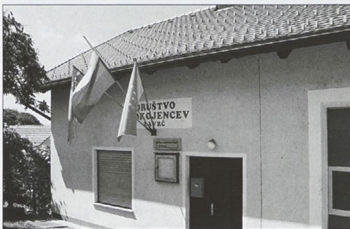
Ko so gasilci PGD Zavrč obnovili ostrežje in prekrili dom, so streho uredili tudi nad društvenimi prostori DU Zavrč.
