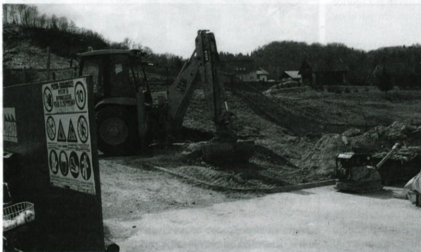
Stroji so se lotili zemeljskih del.
