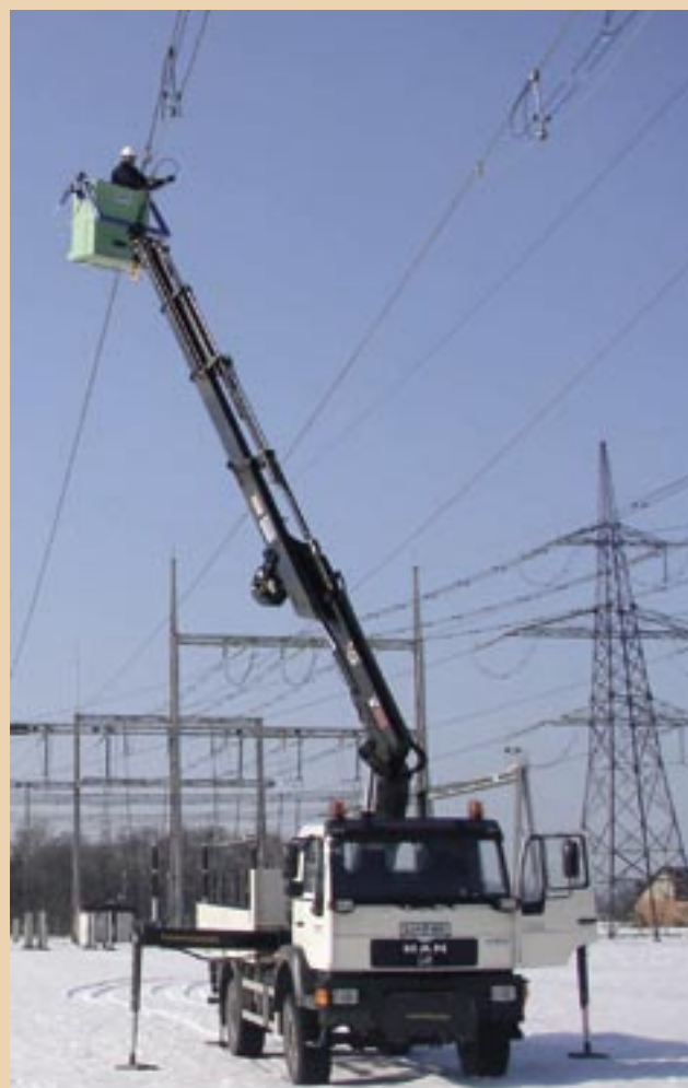
Montaža linijske zapore v RTP Beričevo.
