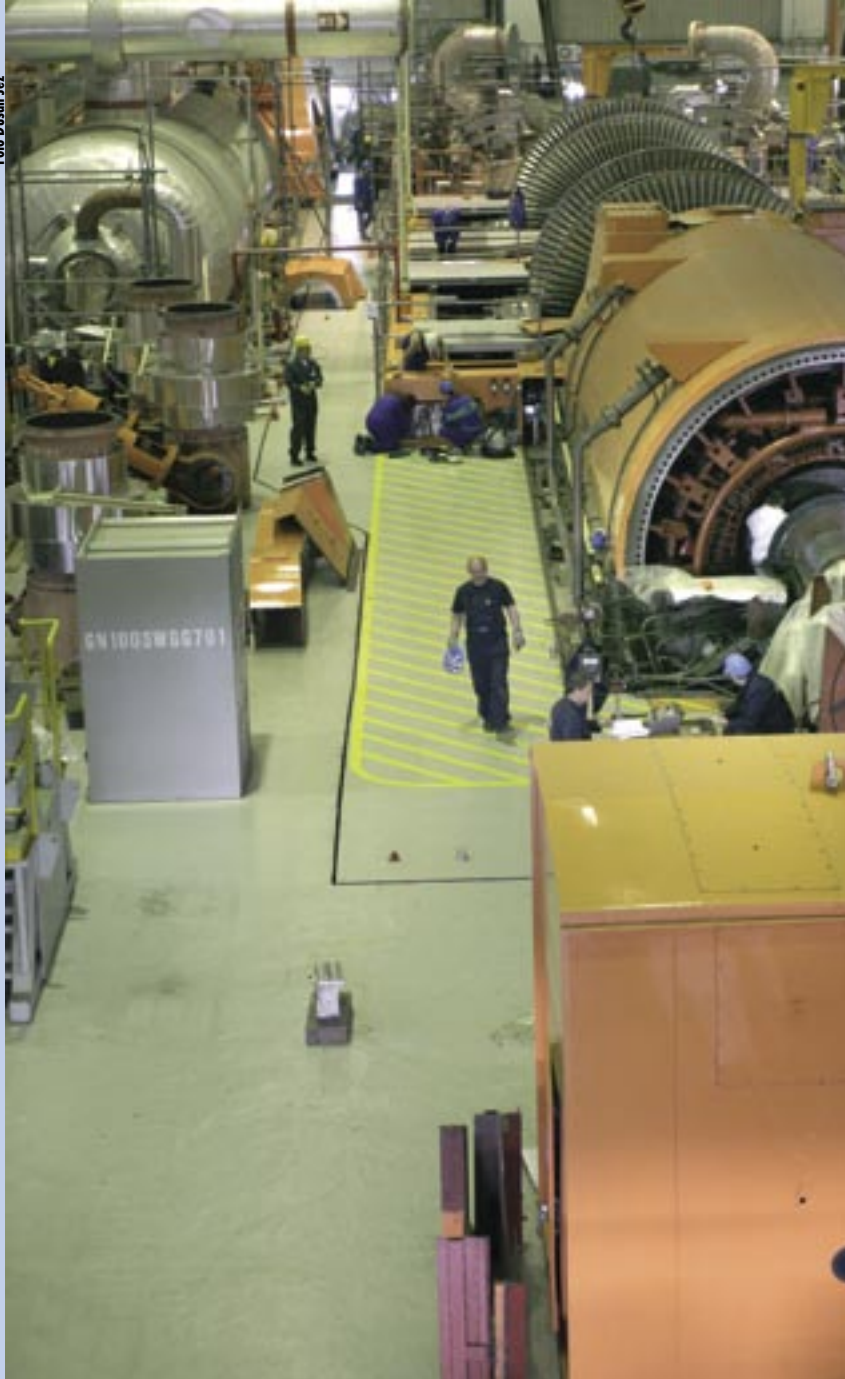
Zamenjava nizkotlačnih turbin, glavna letošnja posodobitev NEK.
