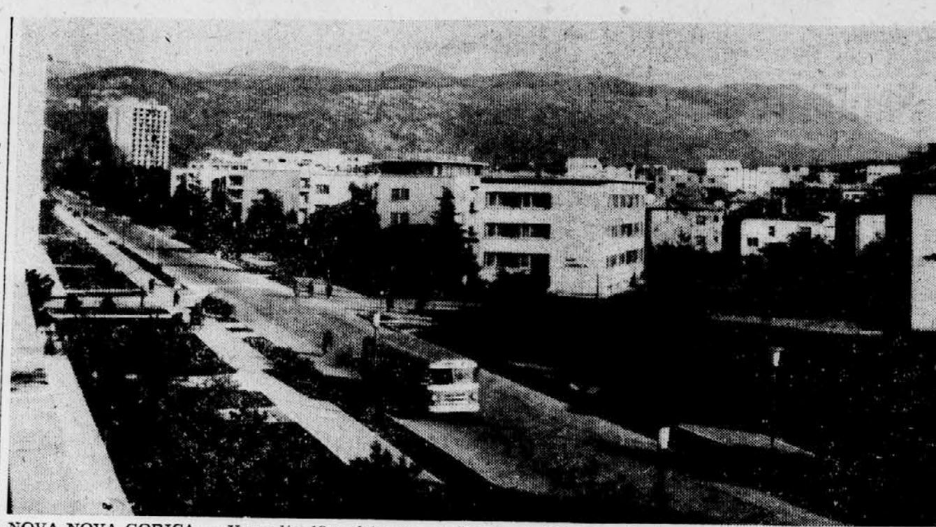
NOVA NOVA GORICA — V ozadju 13-nadstropna stolpnica, v katero se bodo kmalu vselili stanovalci.
