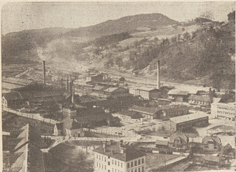
Na Ravnah smo v 20 letih zgradili 18 velikih industrijskih objektov
