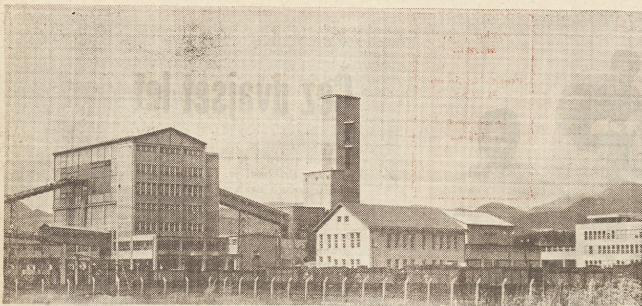
Industrijski objekti na novem jašku rudnika lignita v Velenju, ki jih je zgradila naša celjska enota
