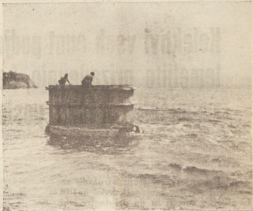
Pričetek gradnje svetilnika pri Debelem rtiču
