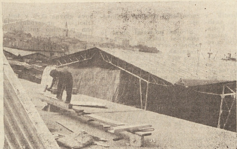
Končana dela na strehi skladišča v Kopru
