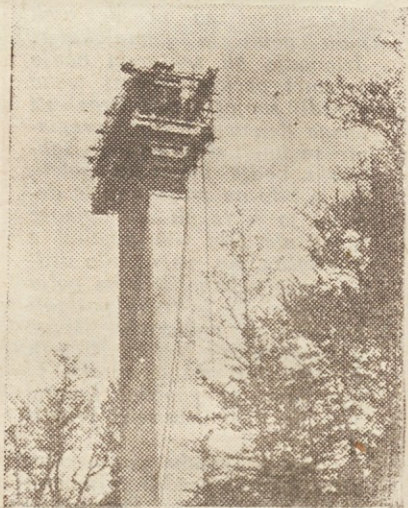
Z gorenjske magistrale: betoniranje opornika za most čez Peračico
