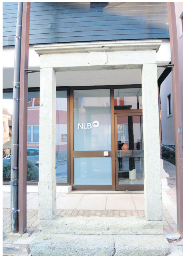
Portal pred stavbo Nove Ljubljanske banke v Mozirju
