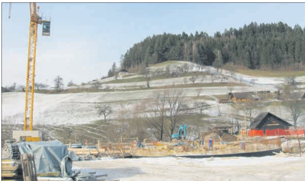
Na gradbišču velikega Kulturnega središča evropskih vesoljskih tehnologij v Vitanju v teh dneh pridno delajo.
