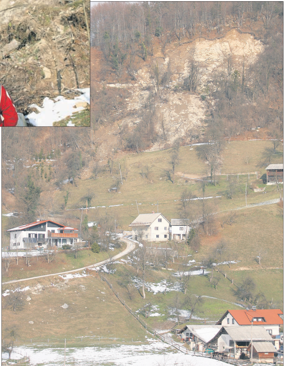
V Tevčah se je poleg že dlje časa padajočih skal, ki so ogrožale hiše v dolini, pred tednom sprožil še zemeljski plaz in »olupil« pol hriba.
