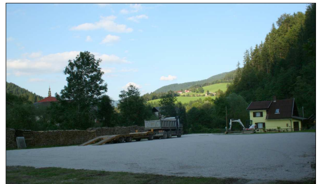
Urejanje površin na Produ za potrebe skladiščenja materiala
