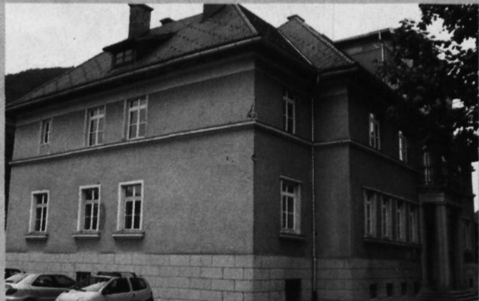
Upravna zgradba Rudnika Senovo v zapiranju
