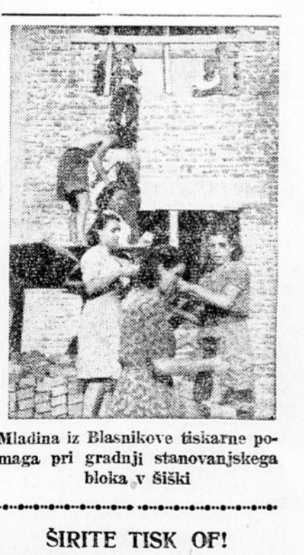
Mladina iz Blaznikove tiskarne pomaga pri gradnji stanovanjskega bloka v Šiški
