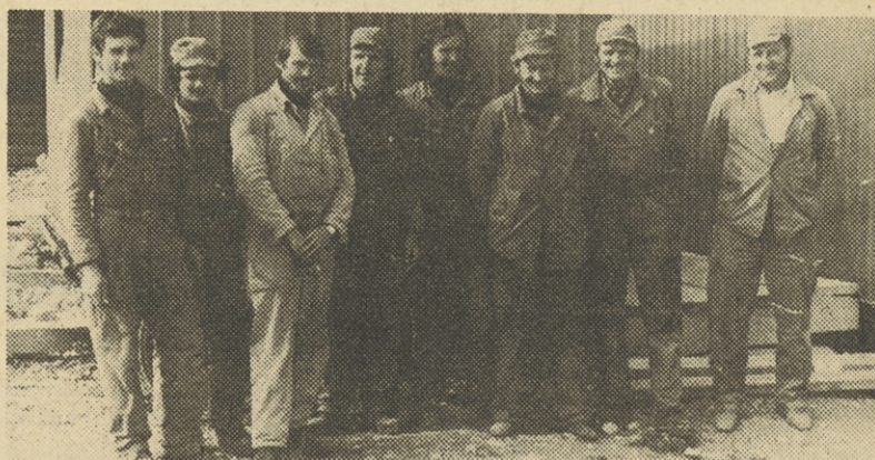
Monterji klimatskih naprav in vodovoda na gradbišču v Čateških Toplicah
