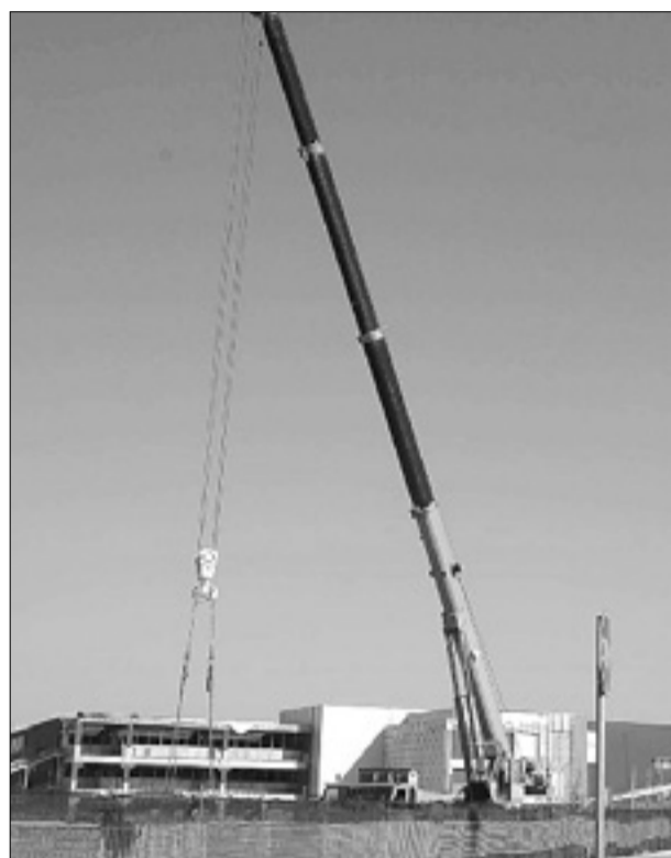
Gradbišče novega komercialnega središča
