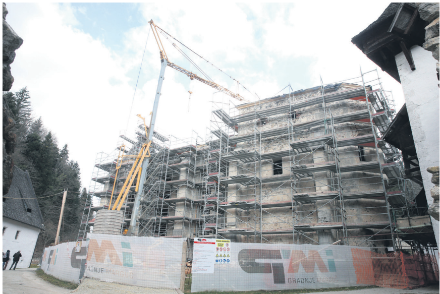
Od lanske jeseni je samostanska cerkev v Žički kartuziji obdana z gradbenimi odri. Nad delom samostanskih ostalin gradijo dvodelno dvižno jekleno in stekleno streho.
