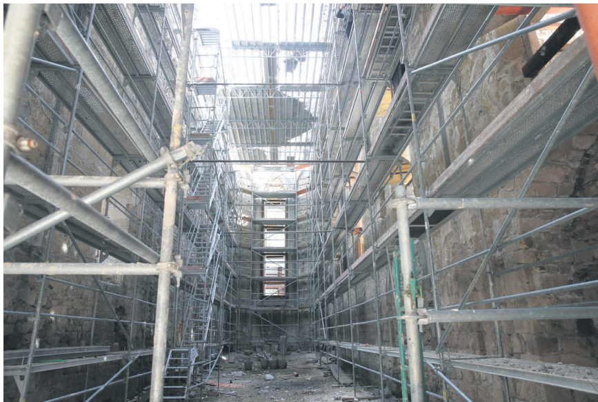
Od lanske jeseni je samostanska cerkev v Žički kartuziji obdana z gradbenimi odri. Nad delom samostanskih ostalin gradijo dvodelno dvižno jekleno in stekleno streho.
