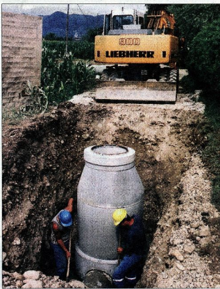
V teh dneh gradi podjetje NIVO Celje kanalizacijski zbiralnik pred razbremljenim kanalom.
